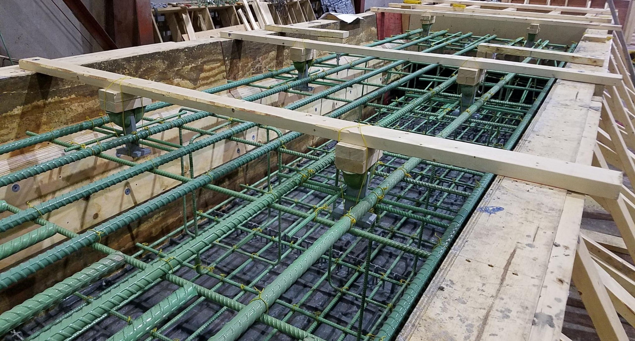
Abutment wall – set-up ready to pour
